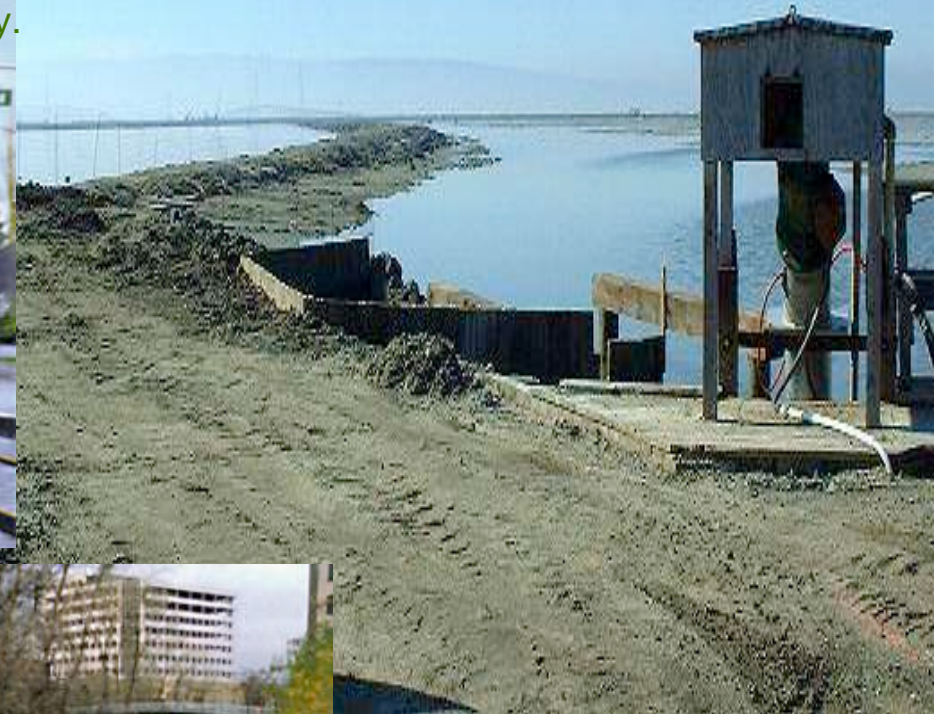
Salt Pond Levees
